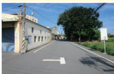
▲埔鹽鄉大新路2巷(彰36) 道路改善工程
