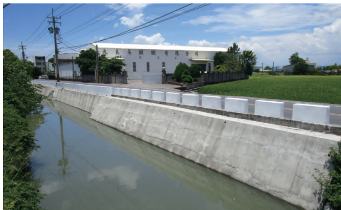
▲埔鹽鄉瓦瑤排水(出水村中義宮旁及埔港路56號之15號前) 護岸改善工程
