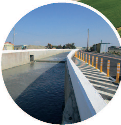
▲114年角樹村埔鹽排水幹線區排完工照
