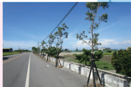
▲埔鹽鄉內植栽工程 (石埤村成功路)
