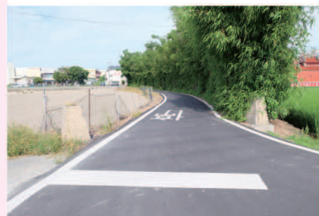
▲新興村員鹿路三段689號附近 等3處道路路面改善工程
