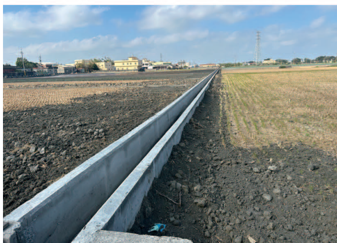
▲新水段937-1地號給水溝改善竣工照
