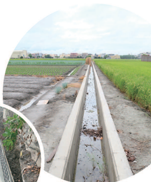
▲義和段883-1地號水利溝改善工程竣工照
