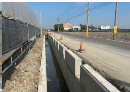
▲東榮段2309等地號給水溝改善施工中
