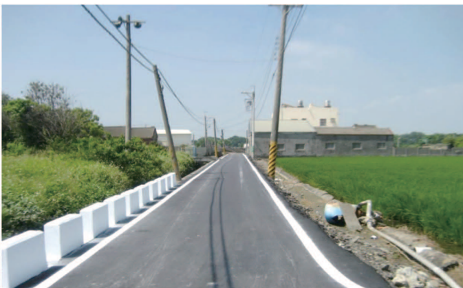
▲埔鹽鄉天盛村周邊道路改善工程
