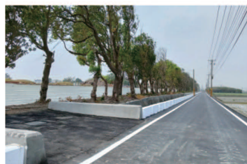
▲第13公墓周邊道路改善
