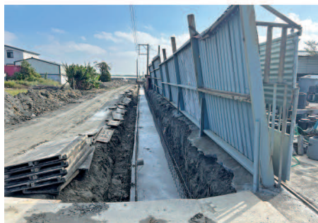
▲三省段331-1地號給水溝改善施工中
