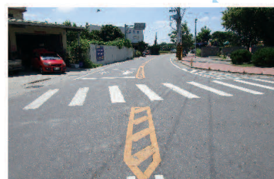
▲埔鹽鄉埔打路(彰48線) 路面緊急改善工程
