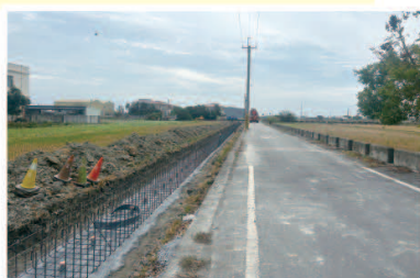
▲113年鎮平(八)農水路改善工程 (永興段1184-4地號)施工中
