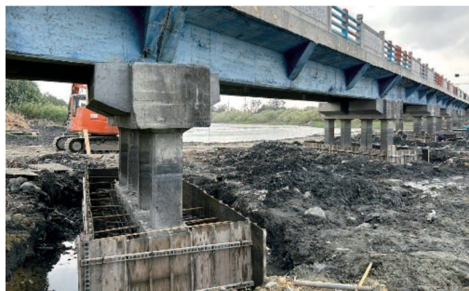
▲埔鹽鄉石埤橋等二座橋梁修建工程 (石埤橋橋底板補強施工中)
