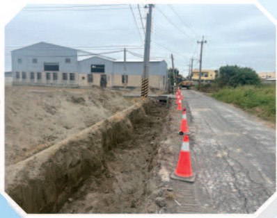
▲永昌段1674、1677-5地號水利溝及路面修復改善施工中
