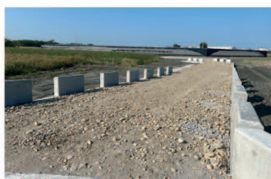
▲111年大廉埤(八)農水路改善工程 (東榮段2252地號)竣工照
