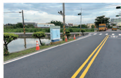
▲埔鹽鄉埔港路(彰48線) 路面及導根板緊急改善工程
