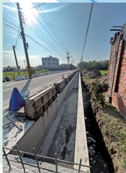
▲東榮段2344地號水利溝改善施工中
