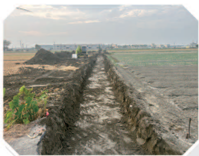
▲三省段744-1地號水利溝施工中
