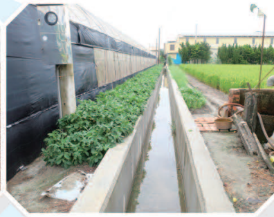
▲三省段768-1地號水利溝改善工程
