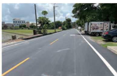
▲埔鹽鄉埔打路(彰48線) 路面緊急改善工程
