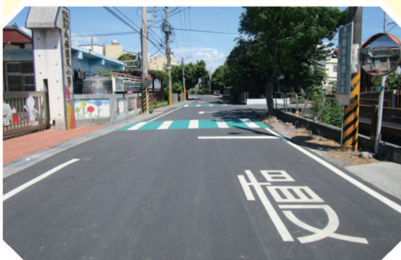
▲埔鹽鄉永樂路(彰36)道路施工改善工程
