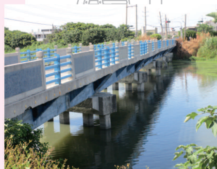
▲埔鹽鄉石埤橋等二座橋梁修建工程 (石埤橋)
