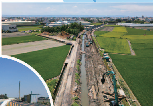
▲114年埔鹽排水角樹及南新村段護岸施工中空拍照
