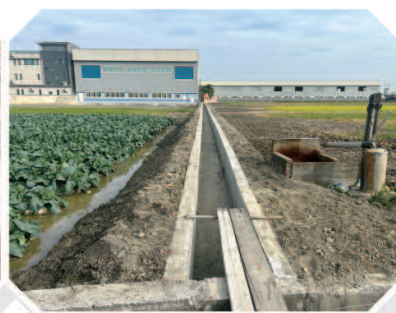
▲三省段761-1、768-1、811-3等地號水利溝改善竣工照
