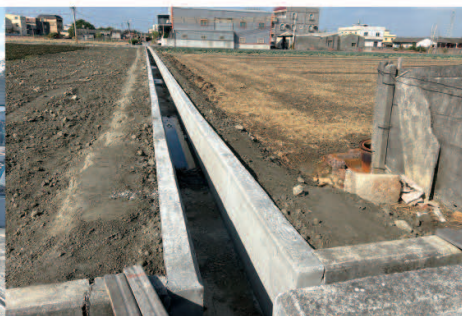
▲新水段895-2地號給水溝改善竣工照
