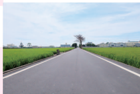
▲角樹村員鹿路一段178巷16號 旁等3處路面改善工程 (廊子村光明路一段)
