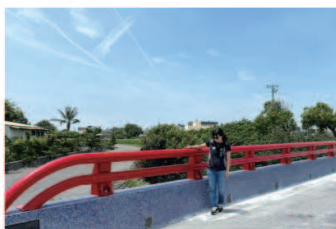
▲溪湖埔鹽排水支線三新橋
