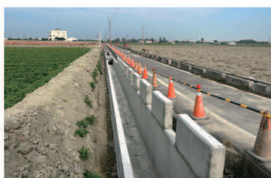
▲112年埔鹽埤(七)農水路改善工程 (和平段1438-3地號)施工中
