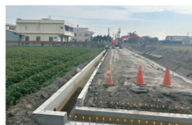
▲112年埔鹽埤(七)農水路改善工程 (和平段1227-2地號)施工中
