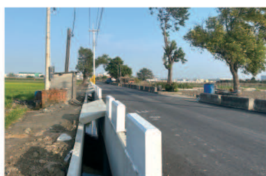
▲111年大廉埤(八)農水路改善工程 (永昌段1662地號)竣工照
