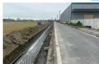
▲113年鎮平(八)農水路改善工程 (永興段1184-5地號)施工中
