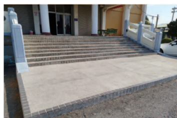
▲第2公墓懷恩堂階梯修繕
