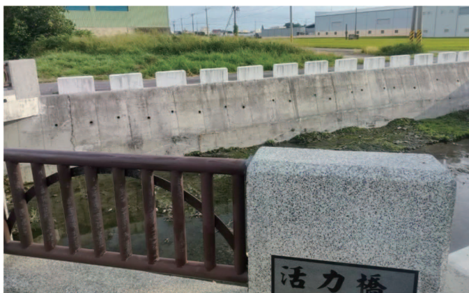
▲埔鹽鄉東寮排水活力橋旁護岸改善工程
