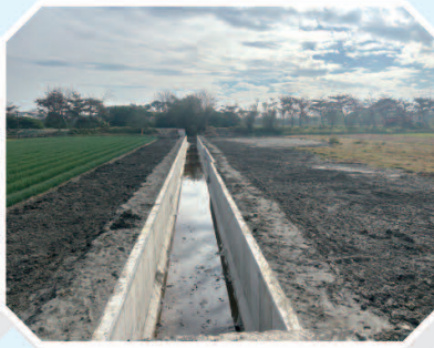
▲義和段377-1地號水利溝改善竣工照
