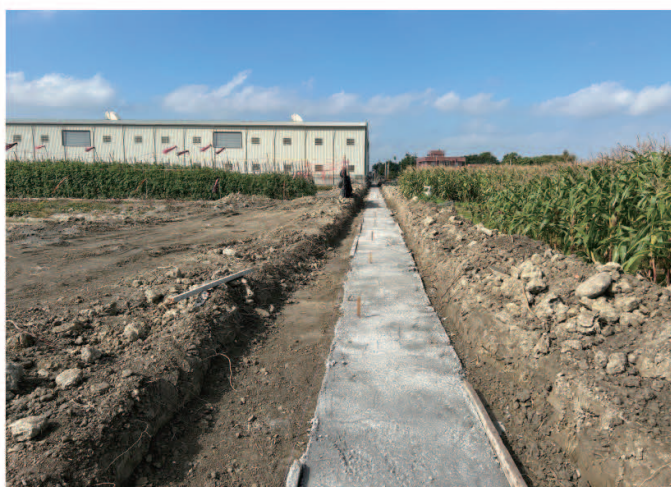
▲南興段1655地號給水溝改善施工中
