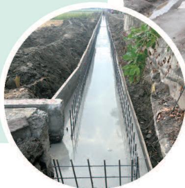
▲義和段883-1地號水利溝施工中
